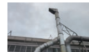
排ガス処理設備 煙突延長工事実施
